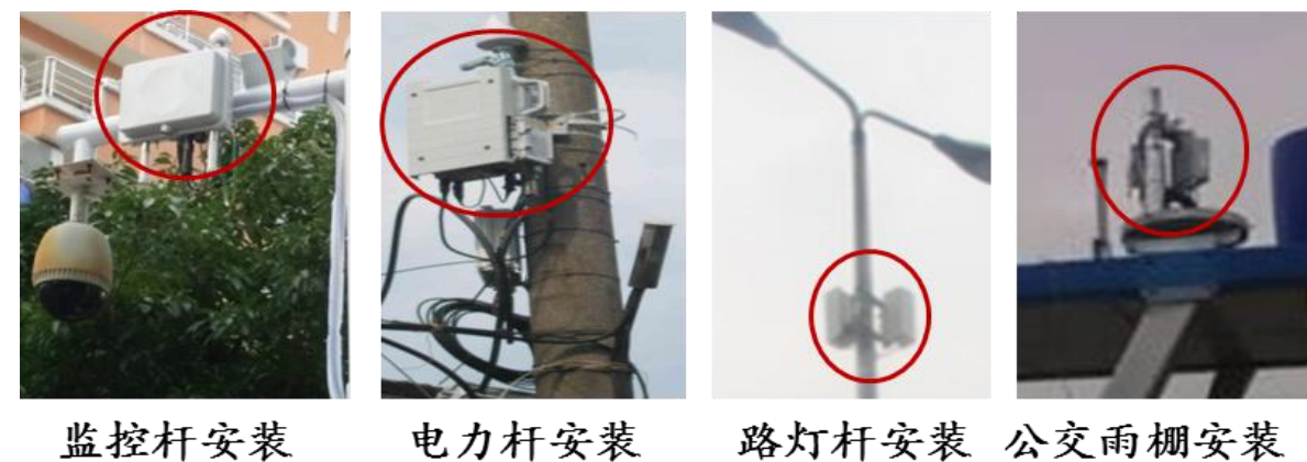
图 4.1- 1 微基站杆塔安装
