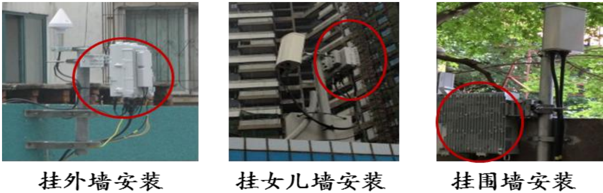
图 4.1- 2 微基站挂墙安装
