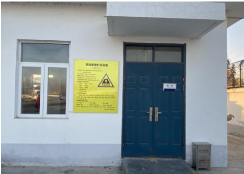
(3) 危险废物暂存间
