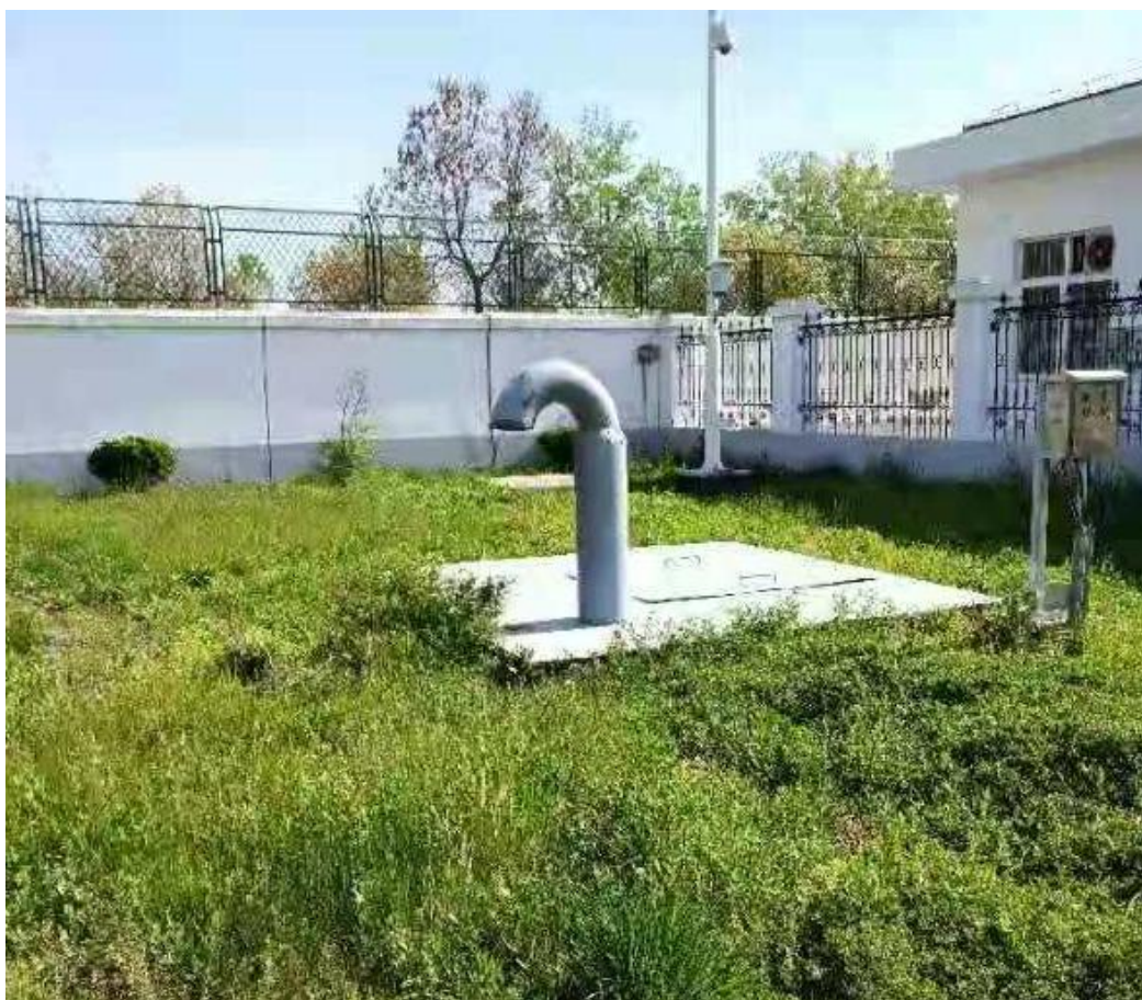
图 3-1-22 集注站现有水源井现状照片
