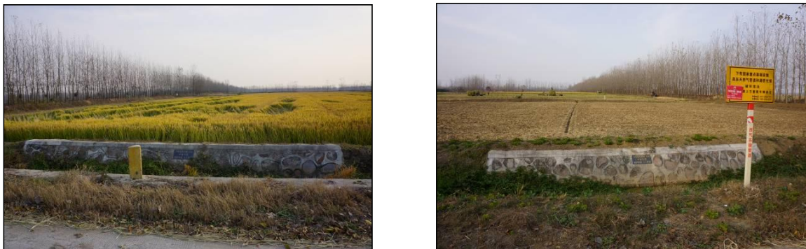
图 3-1-24 现有工程管道临时占地恢复照片
