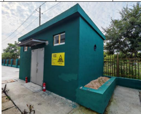
危险废物暂存场所
